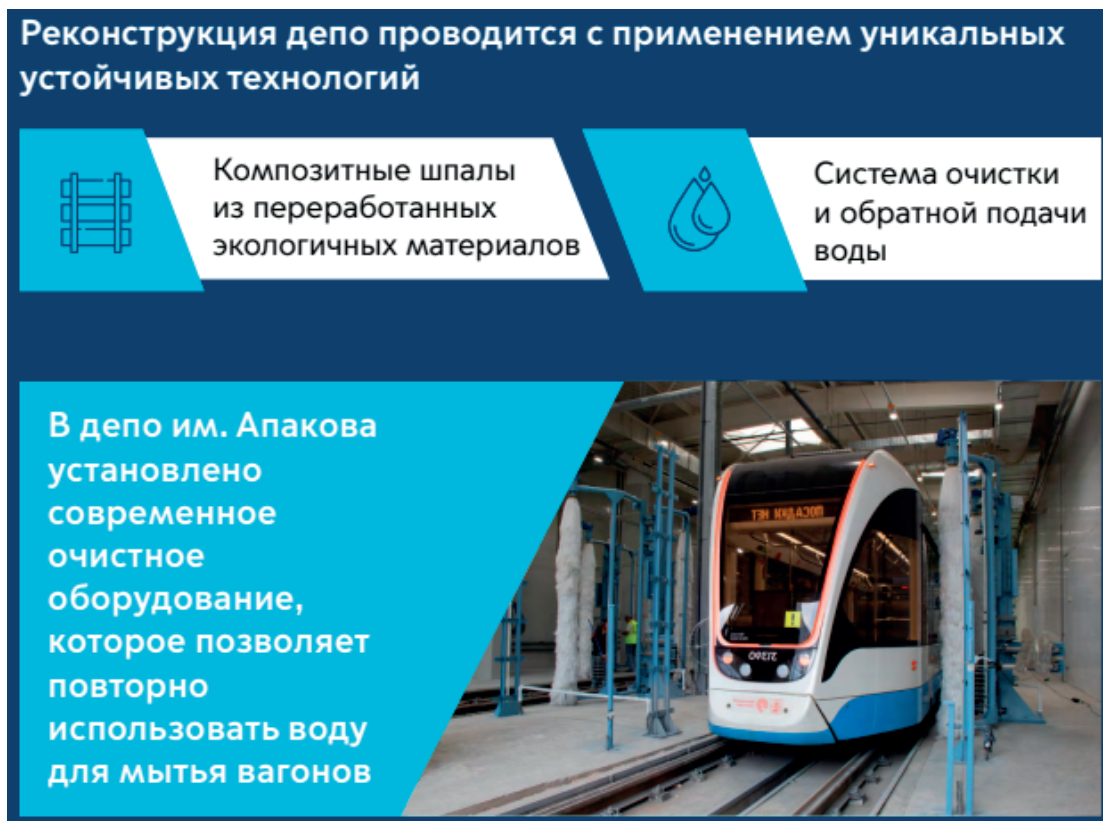
Рис. 5. Реконструкция трамвайного депо им. П.Л. Апакова — уникальный проект с применением устойчивых технологий. Источник: авторы исследования
