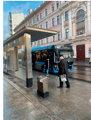
Рис. 4. Неполная защита от осадков из-за конструктивных зазоров между крышей навильона и трамваем. Источник: авторы исследования
